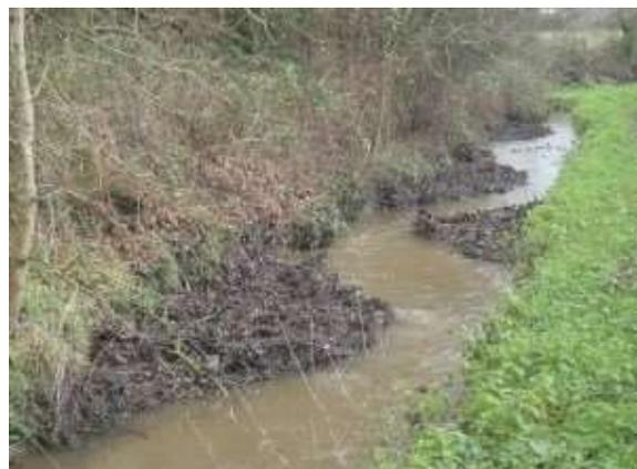
Ce remodelage passe par la mise en place de techniques (épis, banquettes végétales, pose de blocs épars, fixation d'embâcles) qui permettent de recréer de la sinuosité au sein du lit mouillé.
